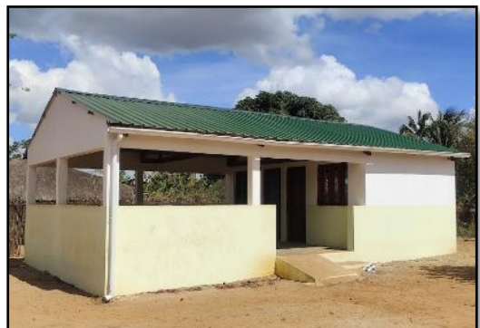
Dia4_Centro de Salud de Minheuene_Detalle nueva construcción
