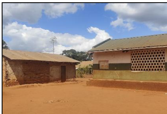
Dia3_Escuela de Nanjua_Detalle salas de aula convencionales y bloque administrativo precario
