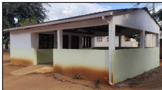
Dia4_Centro de Salud de Meza_ Detalle nueva construcción
